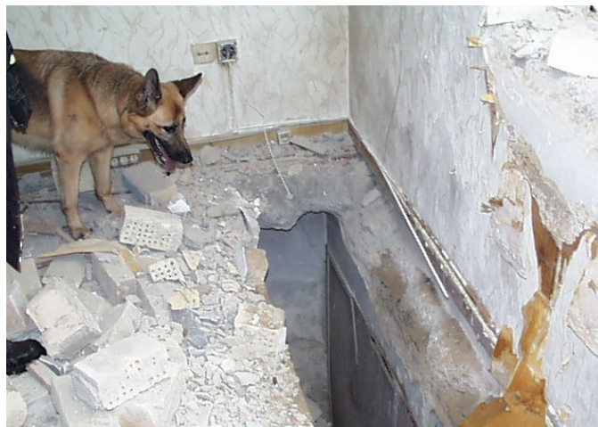
Bild 2: Verschüttetensuche in einem Wohnhaus
